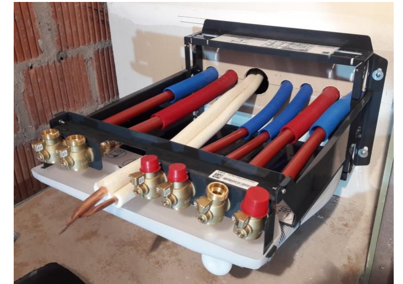
Conexiune la conductele încorporate în perete
