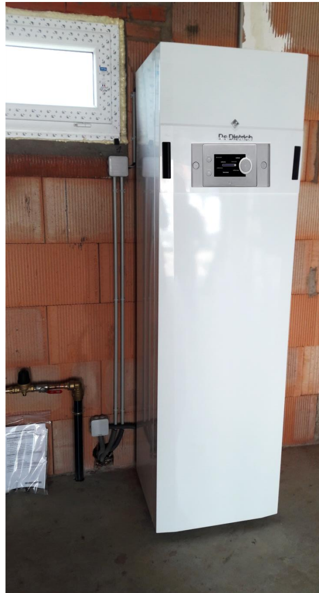
Conexiune in spațiu îngust
